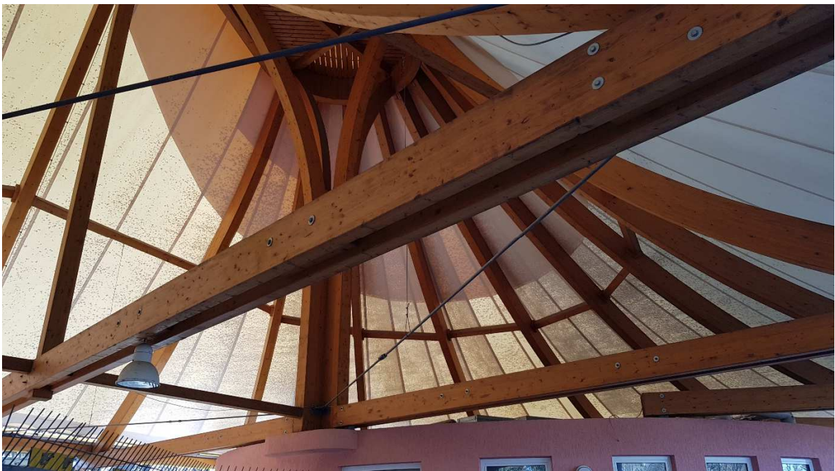
Untersicht der Ostseite
