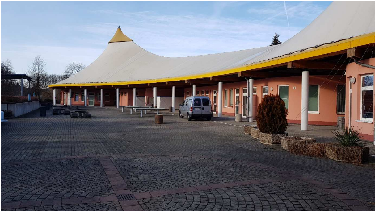
Ansicht Membrandach aus Osten
