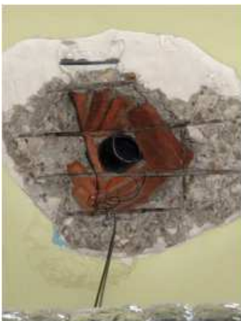
Darstellung verschiedener unzulässiger Decken-/Wanddurchbrüche
