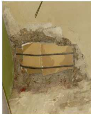
Darstellung verschiedener unzulässiger Decken-/Wanddurchbrüche
